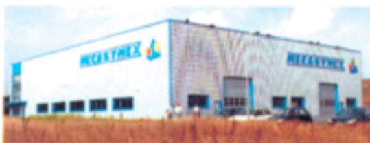
Une réalisation d'AEC Ingénierie, avec ce bâtiment pour SYMEX, à Luigny.
